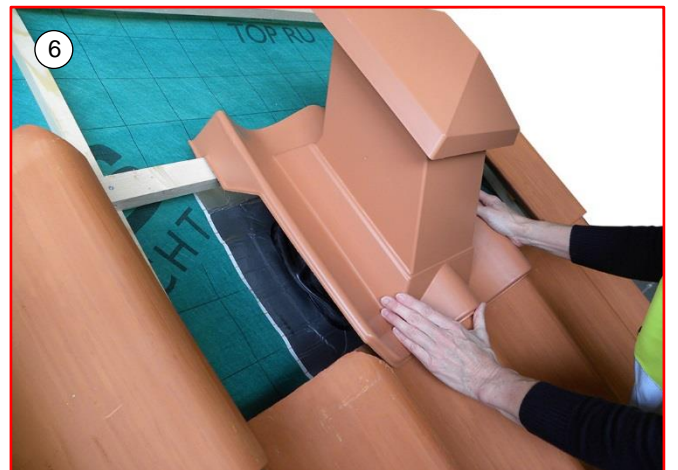
6 Paigalda ventilatsiooniläbiviik roovile.
